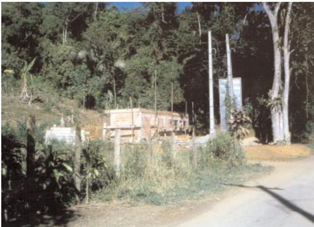
Chantier de maison individuelle à la limite du Parc d'Etat de la Serra do Mar dans un nouveau quartier en pleine évolution — une école a été récemment construite- — situé dans la frange périurbaine d'Ubatuba.
