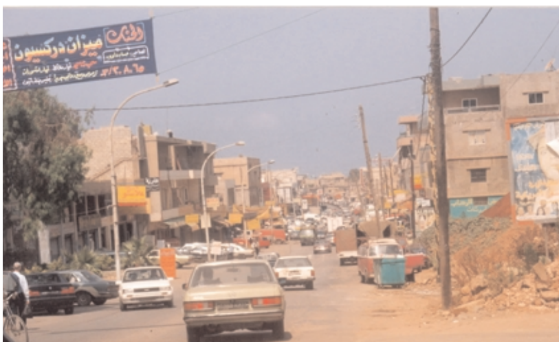
Photo 3. Le quartier illégal d'Ouzai — au long de ses principales avenues se sont développées de nombreuses activités économiques — est situé sur un seul grand terrain détenu en indivision (cliché V. Clerc, 2000)
