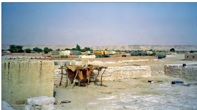
6. L'extension sud de Dirkou en construction, avec à l'arrière-plan la falaise du Kawar (cliché : J. Brachet, 2003)
