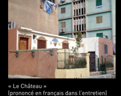
Ouverture de fenêtres sur les pignons / Création d'entrées arrières avec escaliers privatifs / Aménagement de petits jardins / Ajout d'un étage sur le « toit »
