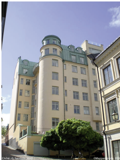
Photo 3. Immeuble de Mikael Blomkvist, Bellmansgatan
